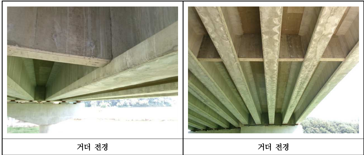
【사진 15.3.27】 거더 전경
