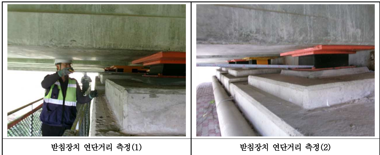
【사진 15.3.37】 교량받침장치 연단거리측정
