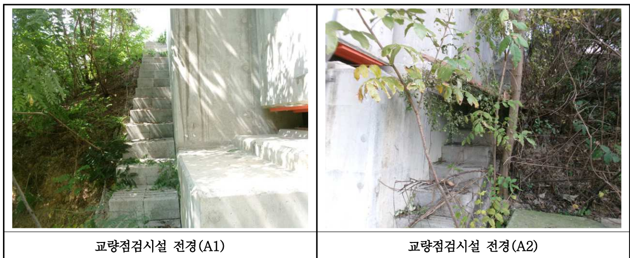
【사진 15.3.48】 교량 점검시설 전경
