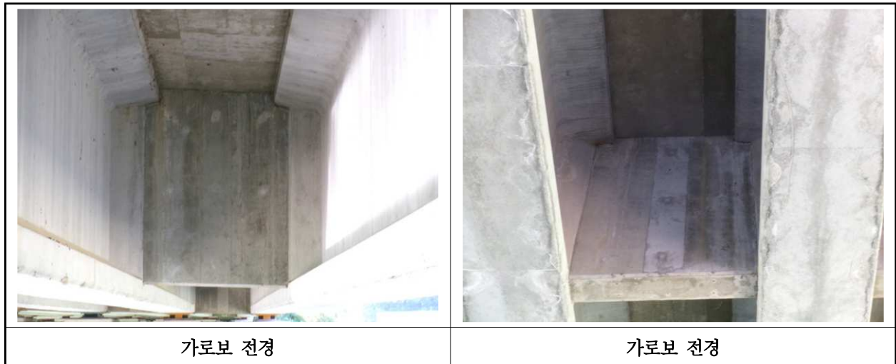
【사진 15.3.6】 가로보 전경
