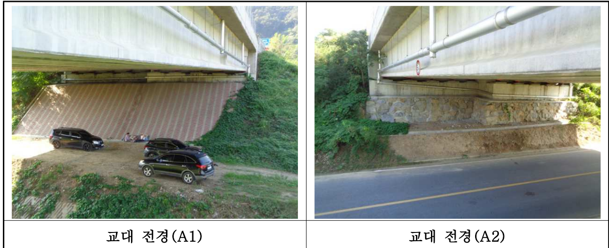
【사진 15.3.8】 교대 전경
