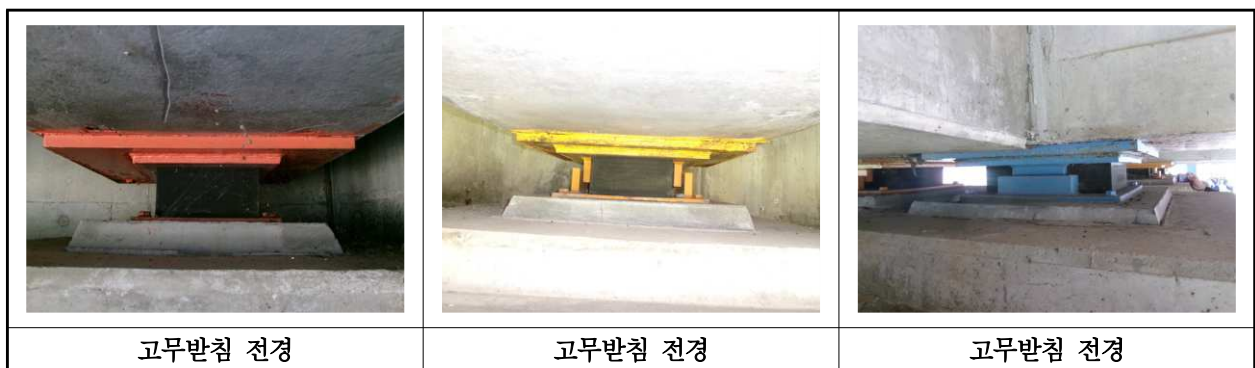
【사진 15.3.12】 교량받침 전경
