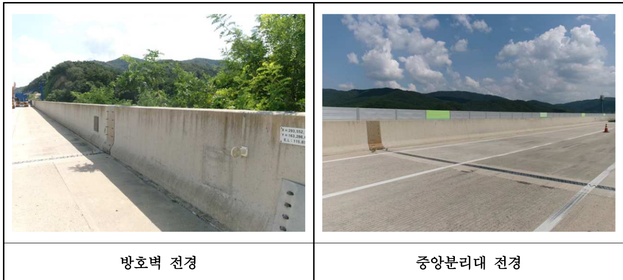
【사진 15.3.46】 방호벽 및 중앙분리대 전경
