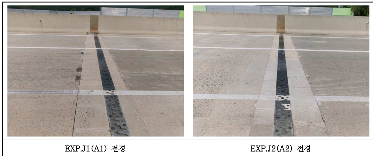
【사진 15.3.39】 신축이음장치 전경
