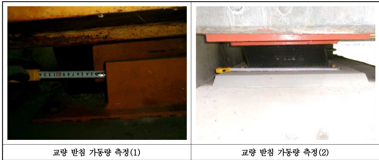
【사진 15.3.38】 교량받침 이동량 측정
