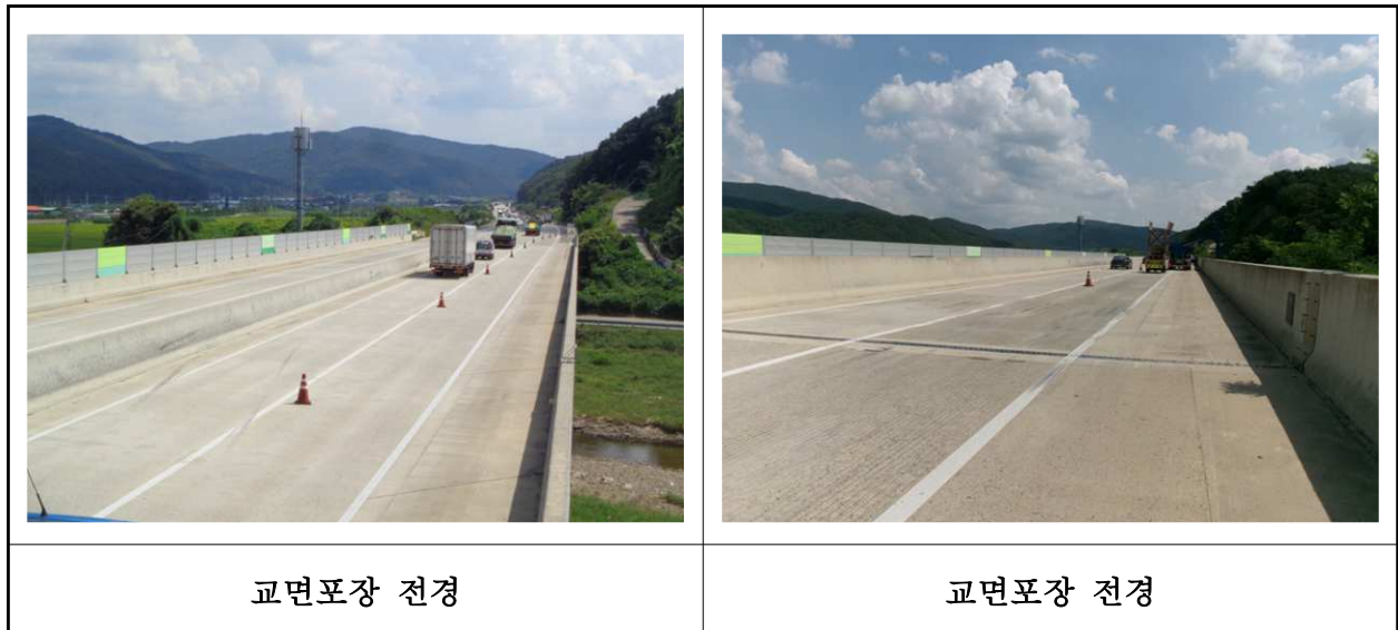
【사진 15.3.42】 교면포장 전경
