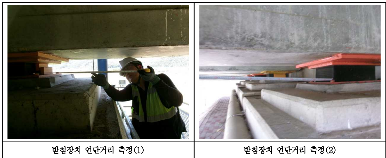
【사진 15.3.14】 교량받침장치 연단거리측정
