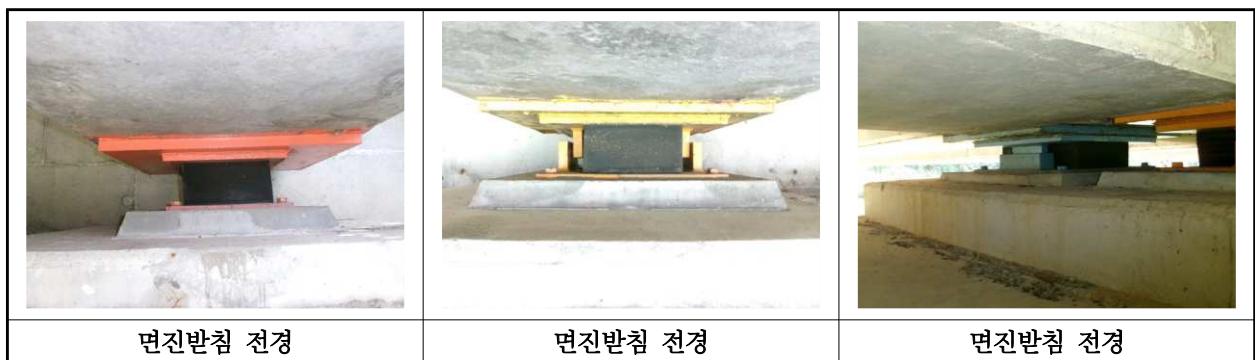
【사진 15.3.35】 교량받침 전경
