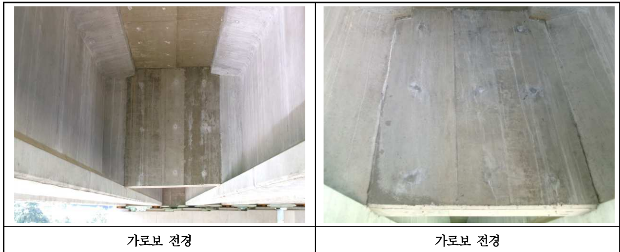
【사진 15.3.29】 가로보 전경
